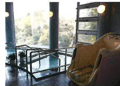
(チェア浴を設置した浴室)
